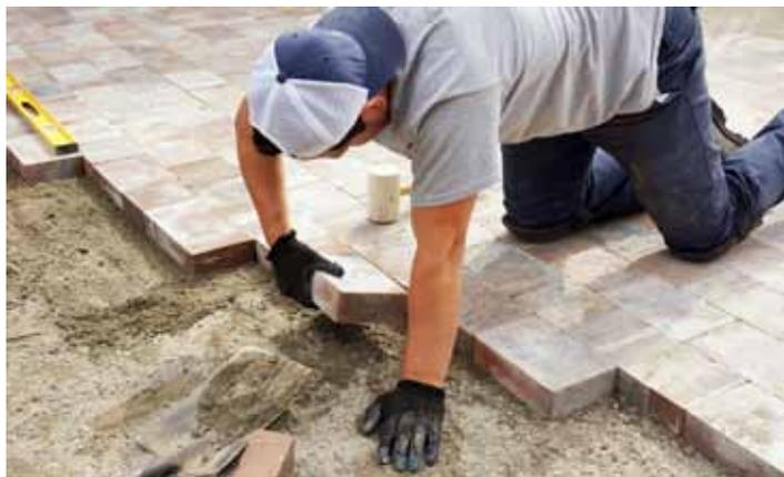
**Camminamenti esterni** realizzati con masselli autobloccanti di primaria marca, carrabili classe C 250, spessore cm 6, tinta in abbinamento al contesto condominiale.
